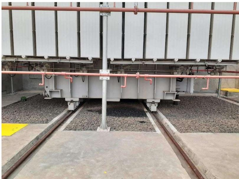
Figura 3 - Vista frontal do transformador na sua "baia" e posição das rodas e trilhos.
